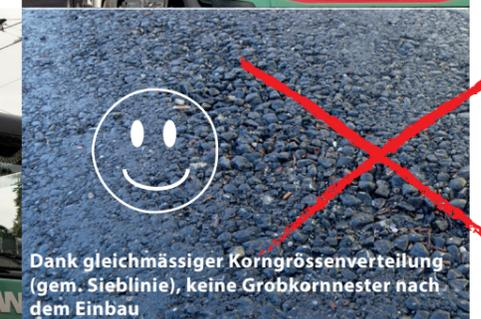
**Dank gleichmässiger Korngrössenverteilung (gem. Sieblinie), keine Grobkornester nach dem Einbau**
